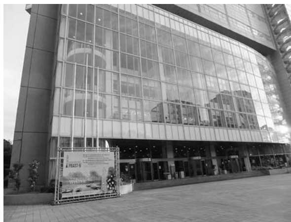
学会会場となった国立台湾大学病院国際コンベンションセンター
