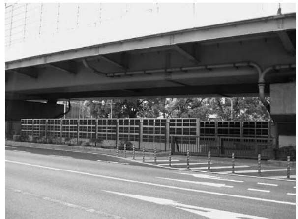
図10 大気浄化用ACFユニットの設置例 (大阪市西淀川区 国道43号)
