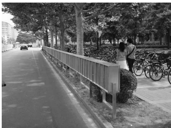
図11 大気浄化用ACFユニットの設置例 (中華人民共和国 北京市 清華大学構内)
