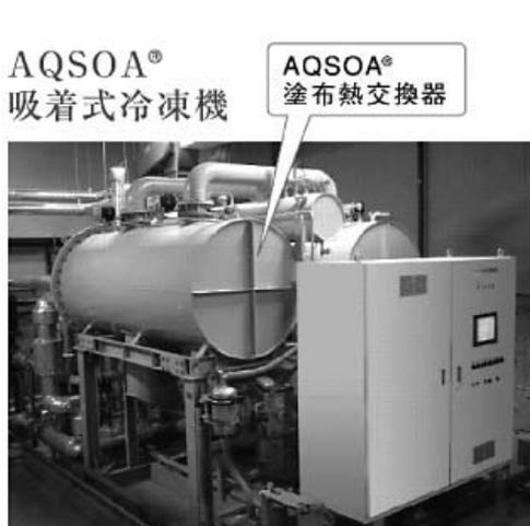
図10. AQSOA-FAM吸着式冷凍機
